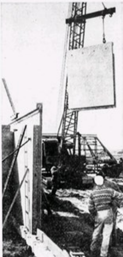
Kranen svinger et af gårthusenes 22 elementer på plads. Det tager en halv snes minutter at placere den treengete væg på fundamentet. Sådan bygges 10 huse om dagen.
